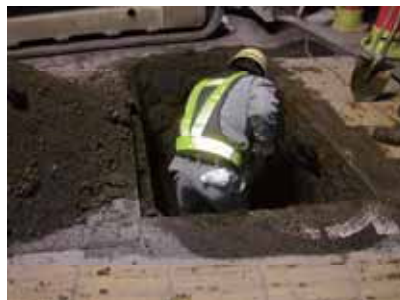
写真11 土木の人力作業
