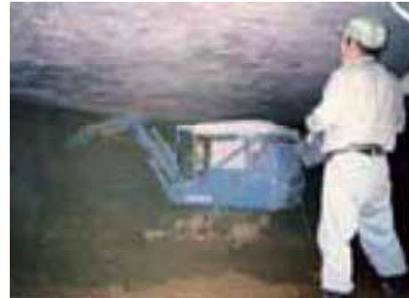
写真13 ALD による施工 (国立西洋美術館)
