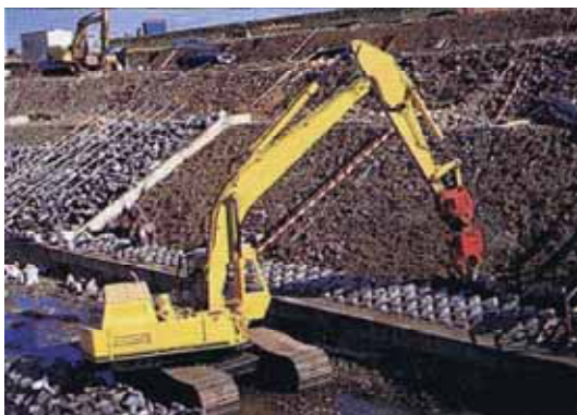
写真23 ブロックマニピュレータ（コンクリート2次製品据付ロボット国土交通省 1987年）
