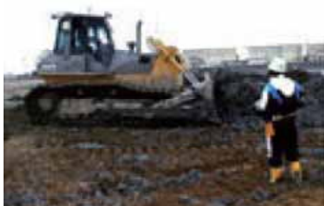
写真14 ブルドーザへのALDの装着
