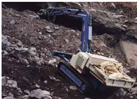
写真24 土嚢設置ロボット
