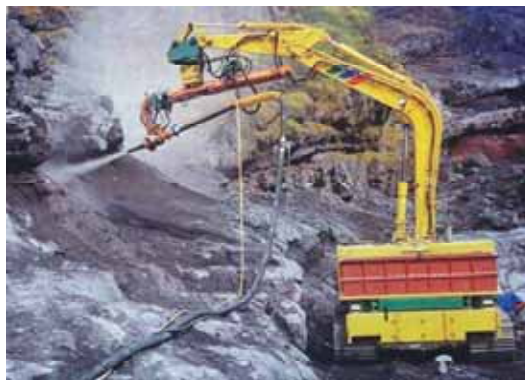
写真25 コンクリート吹付けロボット
