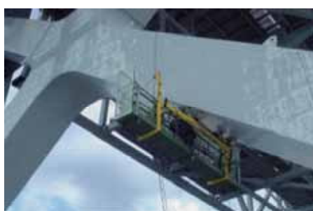
写真3.6 磁石車輪作業台
