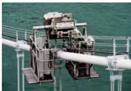
写真3.11 ケーブル作業車
