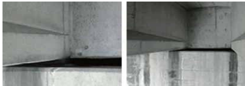
写真3.10 横桁，下部工側面画像
