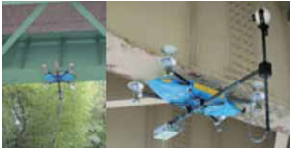
写真3.17 リモート式自走ロボットによる橋梁点検
