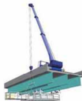
写真3.5 吊下げ作業台の設置
