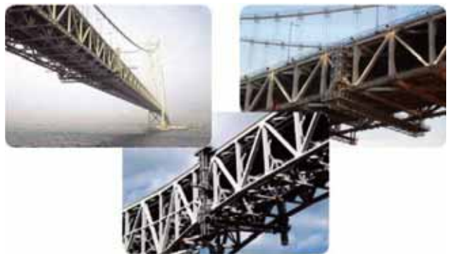
写真3.3 専用作業台
