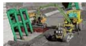
写真16 ダムスリット設置作業
