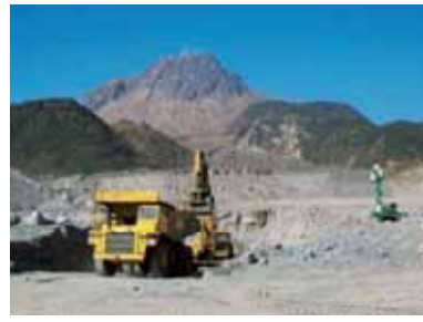
写真6 雲仙普賢岳における無人化施工
