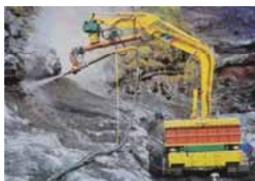
写真2 コンクリート吹付け
