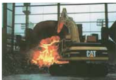
写真1 高炉周辺での積込作業
