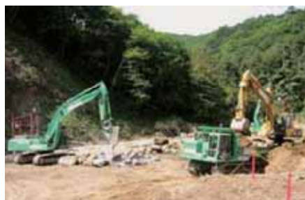
写真7 無人化施工の建機構成例
