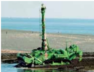
写真4 水中ブルドーザ
