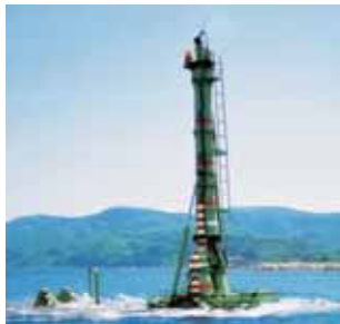
写真5 水中ブルドーザ(水没稼働)
