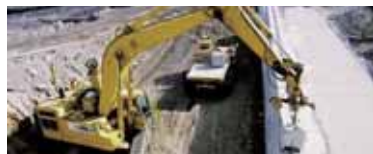
写真15 油圧ショベルによるブロック設置
