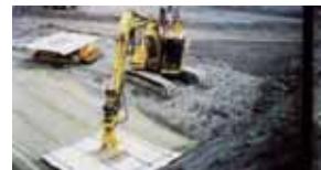
写真17 養生プレート
