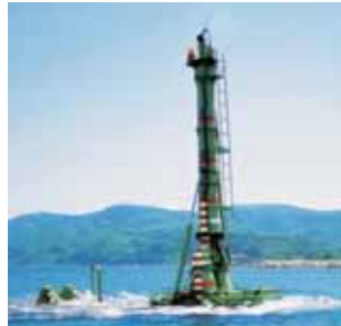
写真5 水中ブルドーザ(水没稼働)
