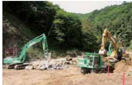
写真7 無人化施工の建機構成例
