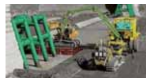
写真16 ダムスリット設置作業
