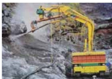
写真2 コンクリート吹付け
