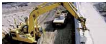
写真15 油圧ショベルによるブロック設置
