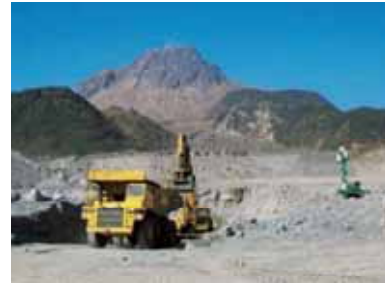
写真6 雲仙普賢岳における無人化施工
