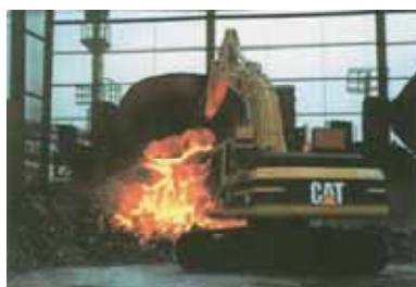
写真1 高炉周辺での積込作業
