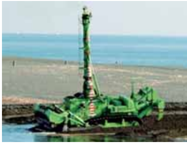
写真4 水中ブルドーザ
