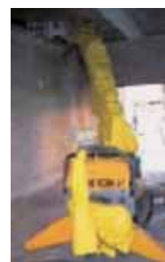
写真3 アスベスト 除去ロボット
