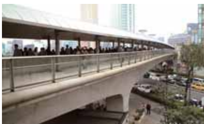
写真14 MM21動く歩道橋
