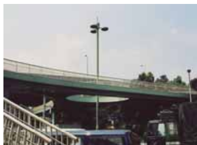
写真11 蓮根歩道橋（東京都板橋区）
