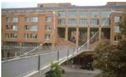
写真17 WULESTEG (建物と橋梁が一体化：ドイツ)
