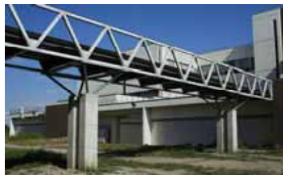
写真19 ものづくり大学第二連絡橋(GFRP歩道橋：埼玉県行田市)
