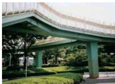
写真12 蓮根歩道橋の主桁部
