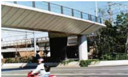
写真13 桜木歩道橋（横浜市）
