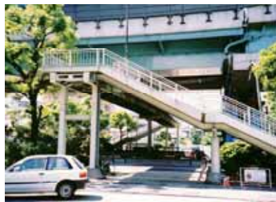
写真7 国道43号の歩道橋（兵庫県）
