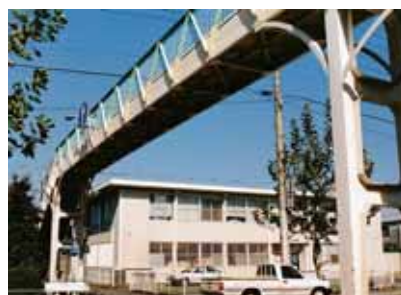
写真3 第4号竜興町跨道橋（トラス形式：岐阜市）
