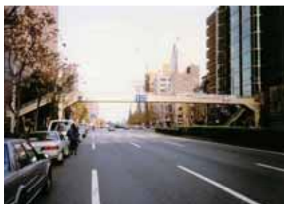
写真6 国道246号の歩道橋（東京都港区）
